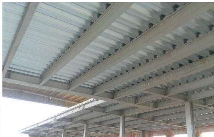
Ocelová konstrukce vestavby stropu - 20 000kg
